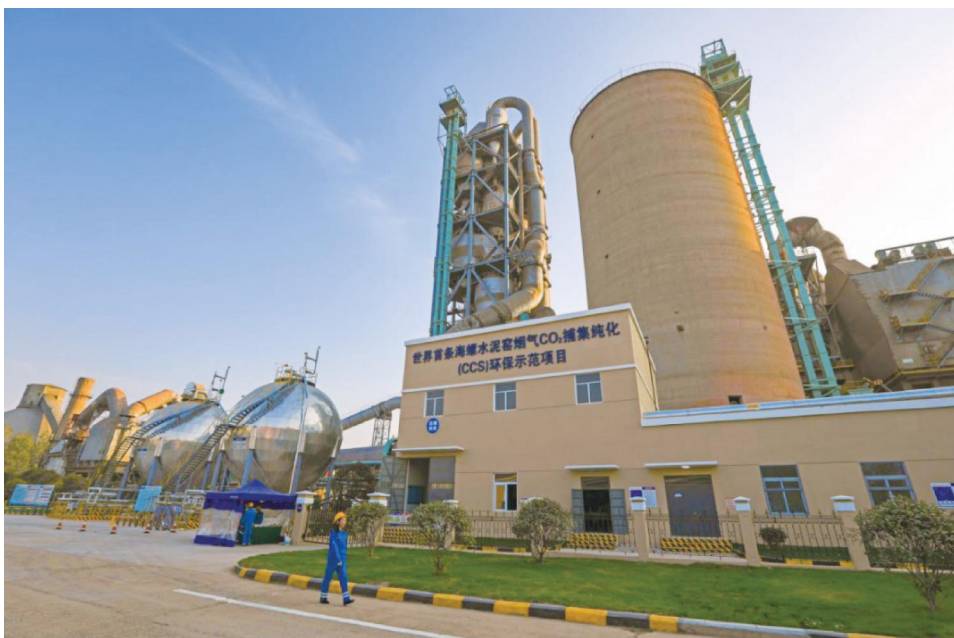
图 2-11 世界首条水泥行业成规模 CO 2 捕集与利用示范线
