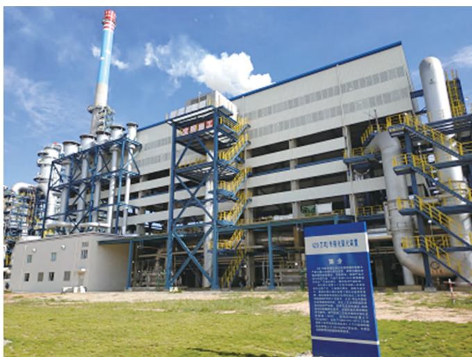
图 9-1 中科炼化 420 万吨 / 年催化裂化装置
