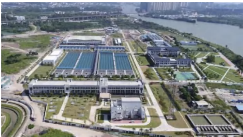
图 10-22 广州北部水厂全景
