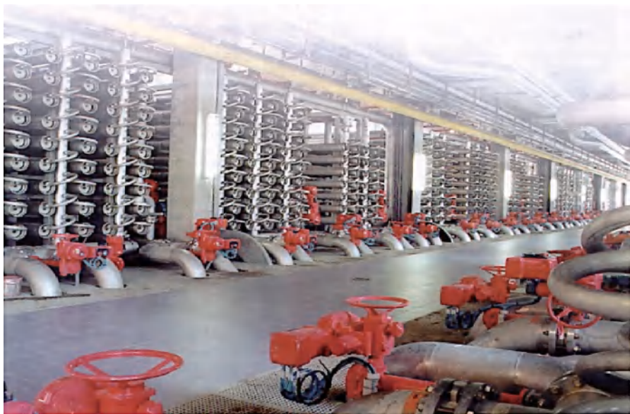
图 10-37 法国巴黎 Mery-sur-Oise 水厂纳滤膜系统
